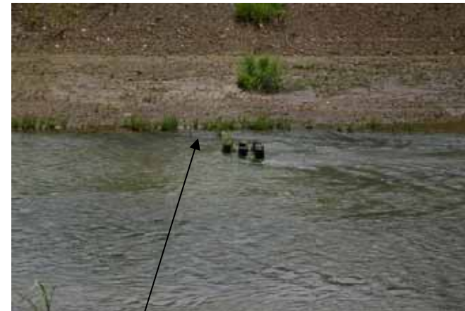
水辺と木杭との間の流速が早まり、流れに変化が生じて環境の多様性が増した。
